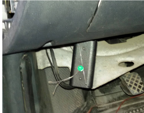
Caja de conexiones bajo salpicadero zona conductor
